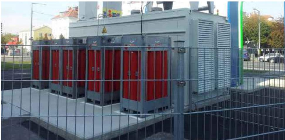
Abbildung 51: Rückseite Wasserstofftankstelle (Flaschenbündel) (Roman Sykora, ÖBFV)
